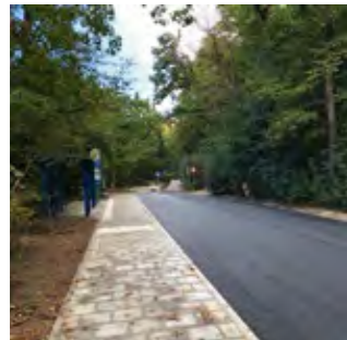
Die Haltestelle an der Kreuzwinkelstraße wurde im Oktober 2024 barrierefrei ausgebaut.
