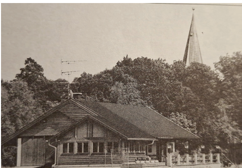
Der Anbau an das Vereinsheim.
